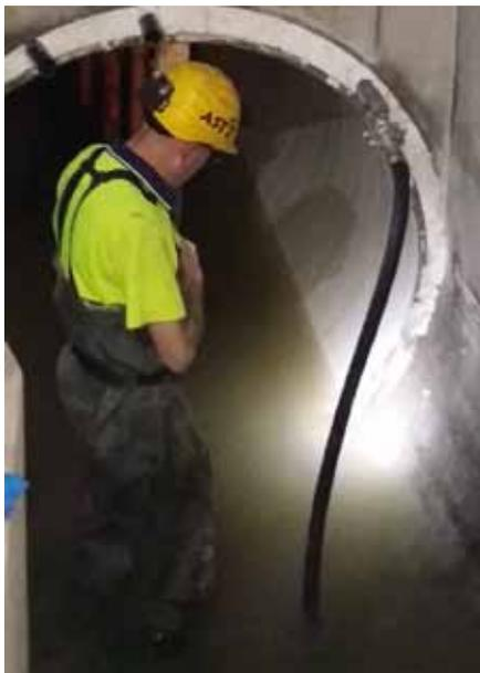
» La tecnología Spiral Wound Lining PVC (SWL) permite rehabilitar tuberías de gran diámetro y flujo por gravedad, mediante la formación de una nueva tubería de PVC conformada helicoidalmente en su interior. La introducción de la maquinaria y los materiales por los pozos de registro evita la realización de obra civil
