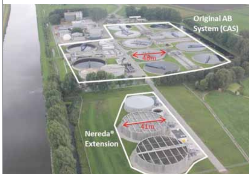
Figura 5. Nereda de la EDAR de Gamerwolde (los dos depósitos Nereda de delante procesan aproximadamente el 40% de las aguas residuales. El sistema AB existente de atrás, el 60%).
