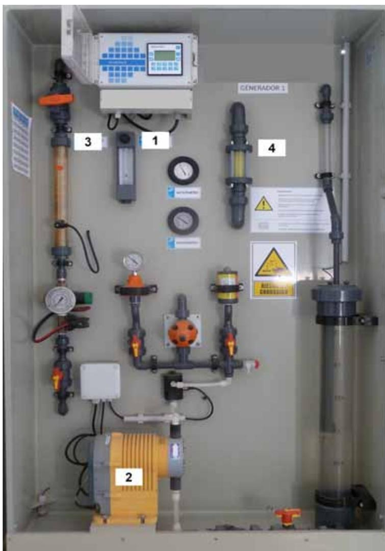
**Nota:** 1 = rotámetro de cloro gas; 2 = bomba dosificadora de clorito sódico; 3 = rotámetro de agua; 4 = visor de dióxido de cloro.
