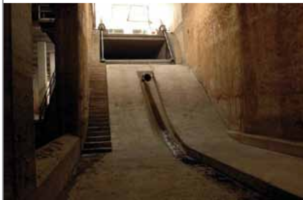
Figura 2. Ejemplo de obra de entrada de un tanque.
