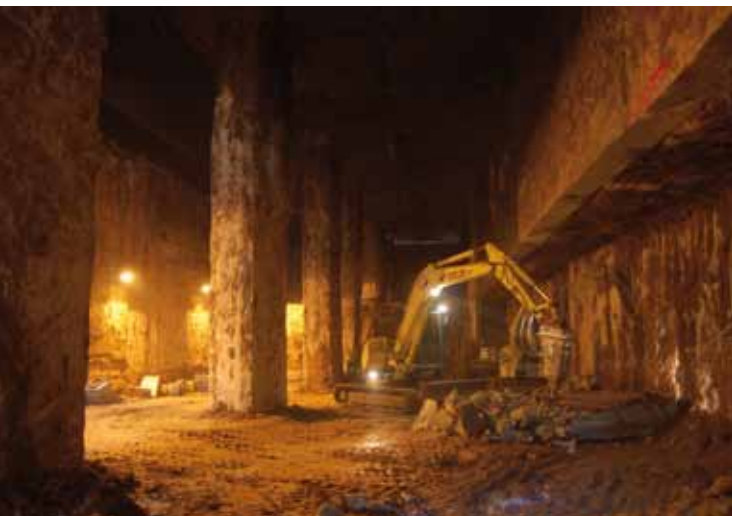
Figura 4. Sistema de construcción invertida de un tanque.
