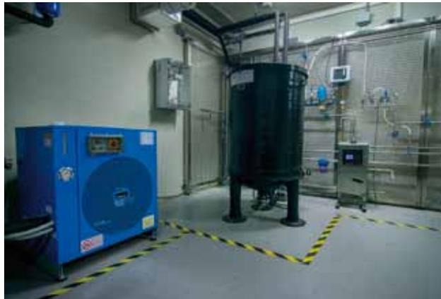
para el circuito cerrado y la adición de compuestos. Tiene un serpentín refrigerado por una enfriadora y una resistencia para variar la temperatura del agua en circuito cerrado. En caso que se quiera homogeneizar el agua al añadir compuestos, el circuito permite recircular el agua en el depósito mediante la manipulación manual de válvulas. También permite recircular productos de limpieza por el circuito cerrado. En la **Figura 5** se muestra el depósito con la enfriadora.
