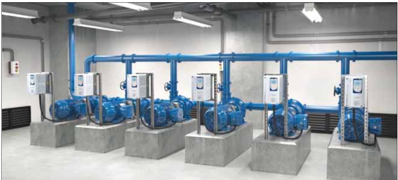
Aplicación de motores de eficiencia energética WEG en una infraestructura de agua.
