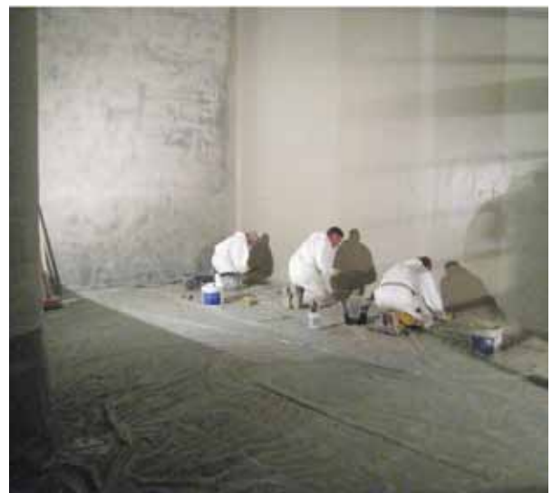
Rehabilitación de un tanque de agua potable con MC-RIM PW.
