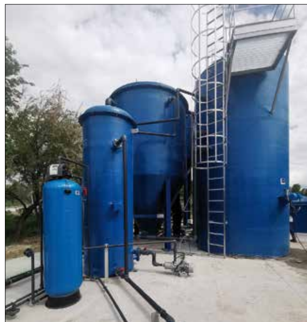
FIGURA 3. Imágenes de la planta demostrativa. Reactor AnMBR (izquierda) y sistema PN/AMX (derecha).
