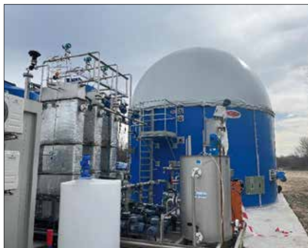
FIGURA 3. Imágenes de la planta demostrativa. Reactor AnMBR (izquierda) y sistema PN/AMX (derecha).
