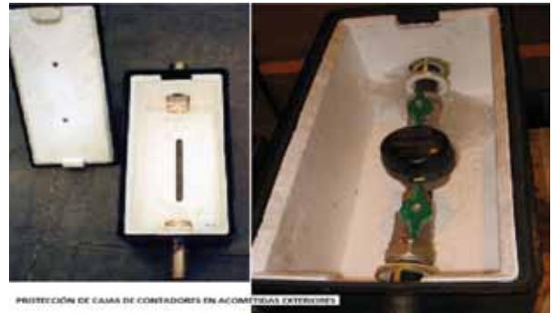
FIGURA 9. Protección de acometida y montaje.
