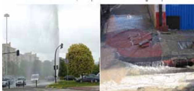
FIGURA 3. Roturas de canalizaciones de agua: visual y con daños.
