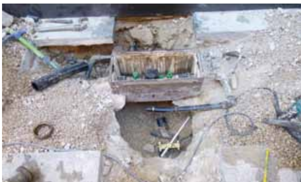
FIGURA 6. Fuga en acometida de obra entregada por instalación indebida y mal montaje.
