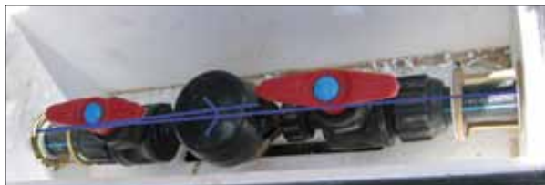
FIGURA 2. Detalle de instalación de un contador sin respetar su correcta nivelación.
