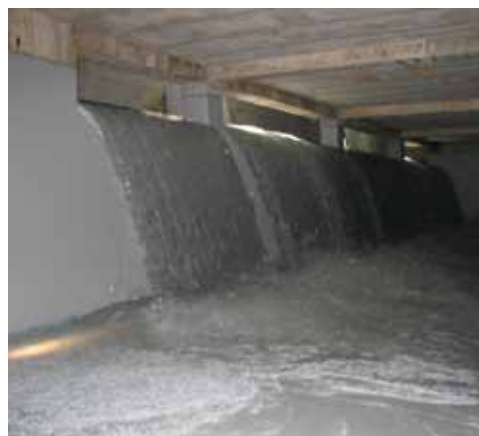
FIGURA 4. Depósito ETAP impermeabilizado. Llenado para pruebas.
