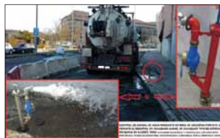
FIGURA 17. Columna portátil para registro cargas y usos de todo tipo, en cualquier lugar de la red.
