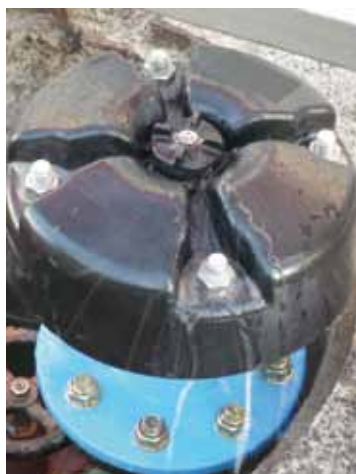
FIGURA 3. Fallos en los purgadores de hidrantes (izquierda) y ventosas (derecha).
