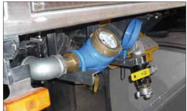
FIGURA 15. Contador en entrada a camión cisterna.
