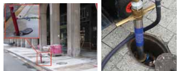
FIGURA 18. Columnas portátiles para registro usos simples en obras y otros.
