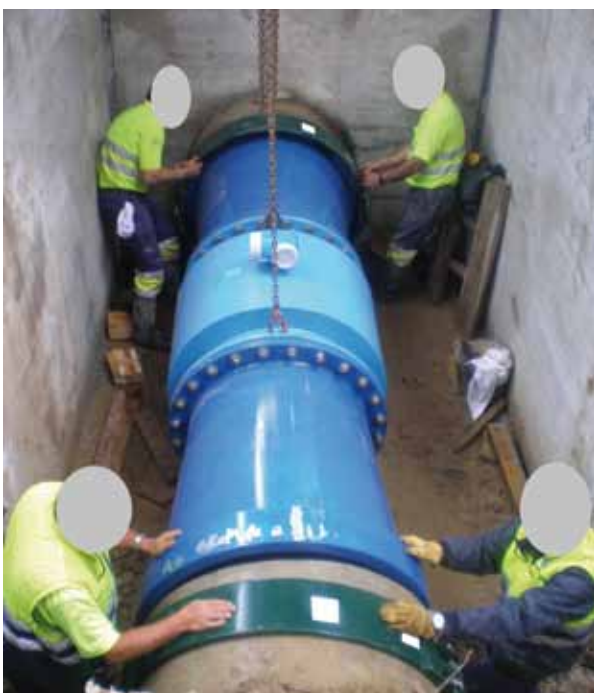
FIGURA 9. Implantación de un control de caudal a la salida de una ETAP.
