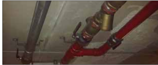
FIGURA 14. Derivación desde una red de incendios en interior edificación.
