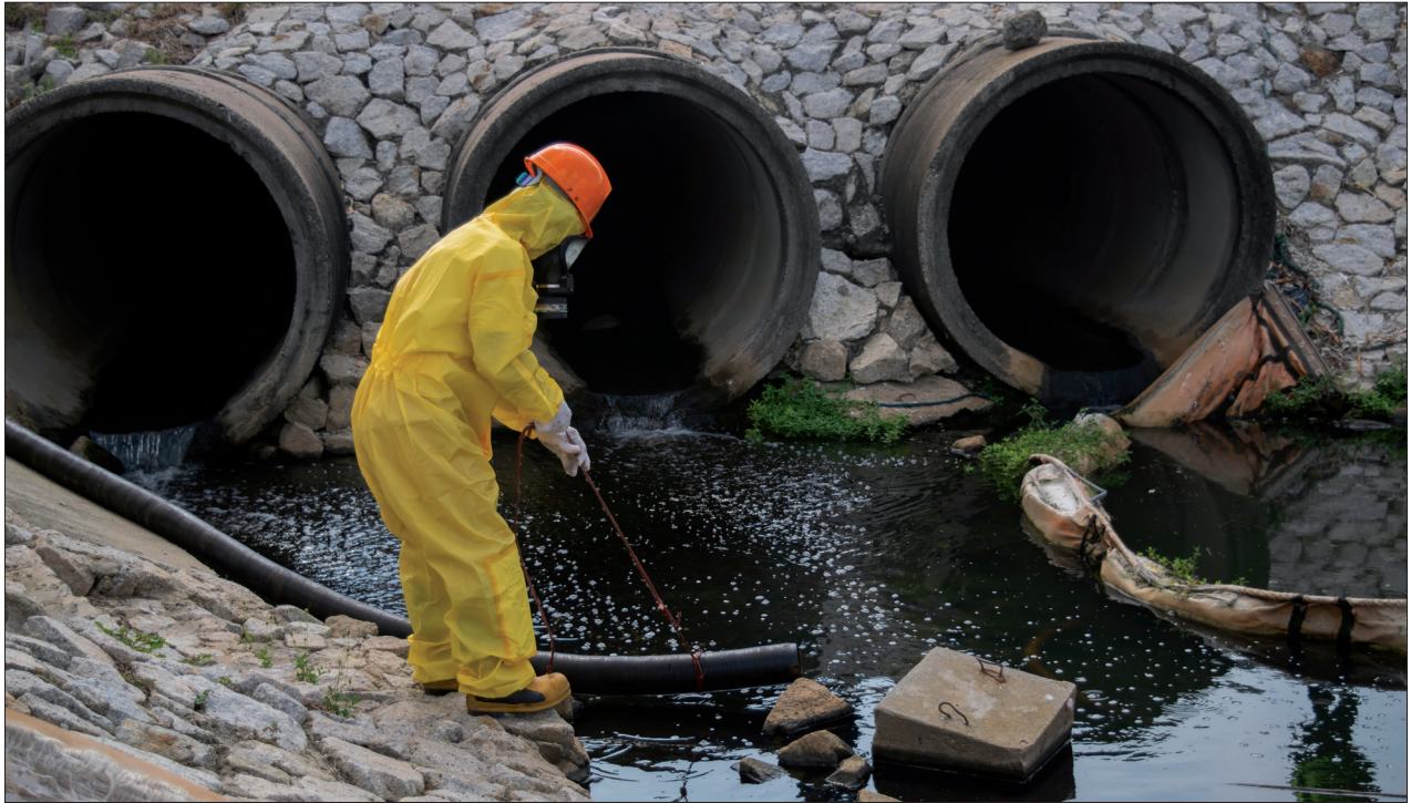
FIGURA 11. El control de vertidos debe ser una actividad, con las medidas de protección, seguridad y formación adecuadas para aquellos trabajadores que la lleven a cabo.
