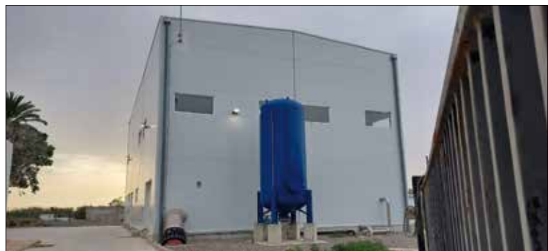
Vista exterior de la EBAR.
