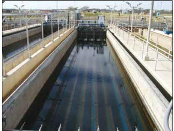
**FIGURA 3.** Ejemplo de instalación para reducción de fósforo.
