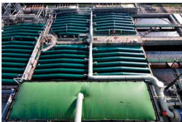
Figura 2. Imágenes del biofiltro de altas prestaciones (BAP) instalado en la desodorización de las emisiones de la EDAR de la industria alimentaria. Fuente: Labaqua.
