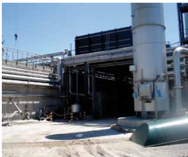
Figura 2. Imágenes del biofiltro de altas prestaciones (BAP) instalado en la desodorización de las emisiones de la EDAR de la industria alimentaria. Fuente: Labaqua.
