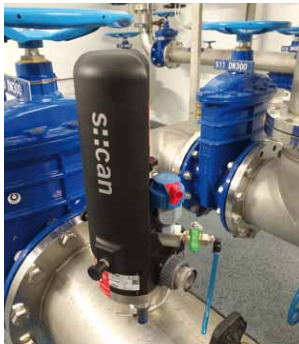
FIGURA 3. La carcasa del pipe::scan proporciona seguridad adicional a los sensores y a los operarios
