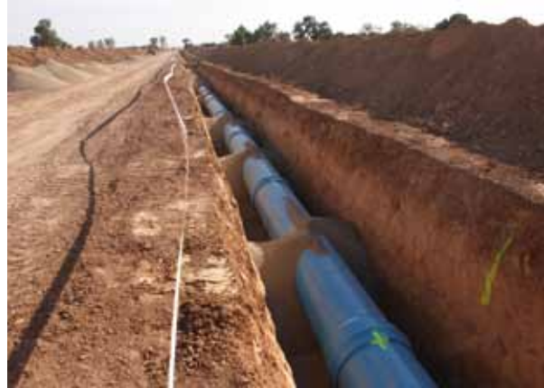
FIGURA 3. Altos rendimientos de instalación.
