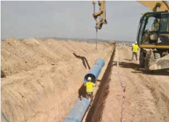
FIGURA 2. Instalación de la tubería TOM de PVC-O.
