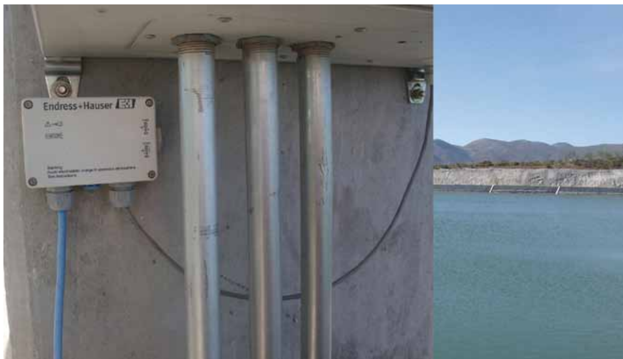
FIGURA 3. Waterpilot en México. La caja de conexiones proporciona una conexión segura y directa de la sonda de nivel con el sistema de control.
