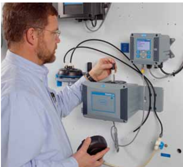
FIGURA 3. SU5400 con instalación de SC200 en una planta de Alemania.
