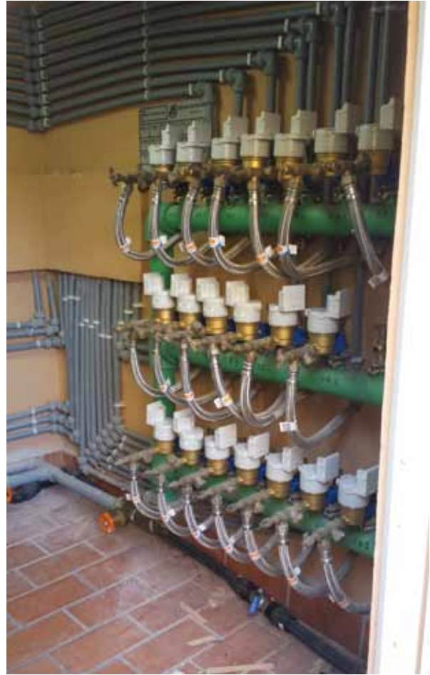
FIGURA 4. Batería de contadores con el módulo MyWater.
