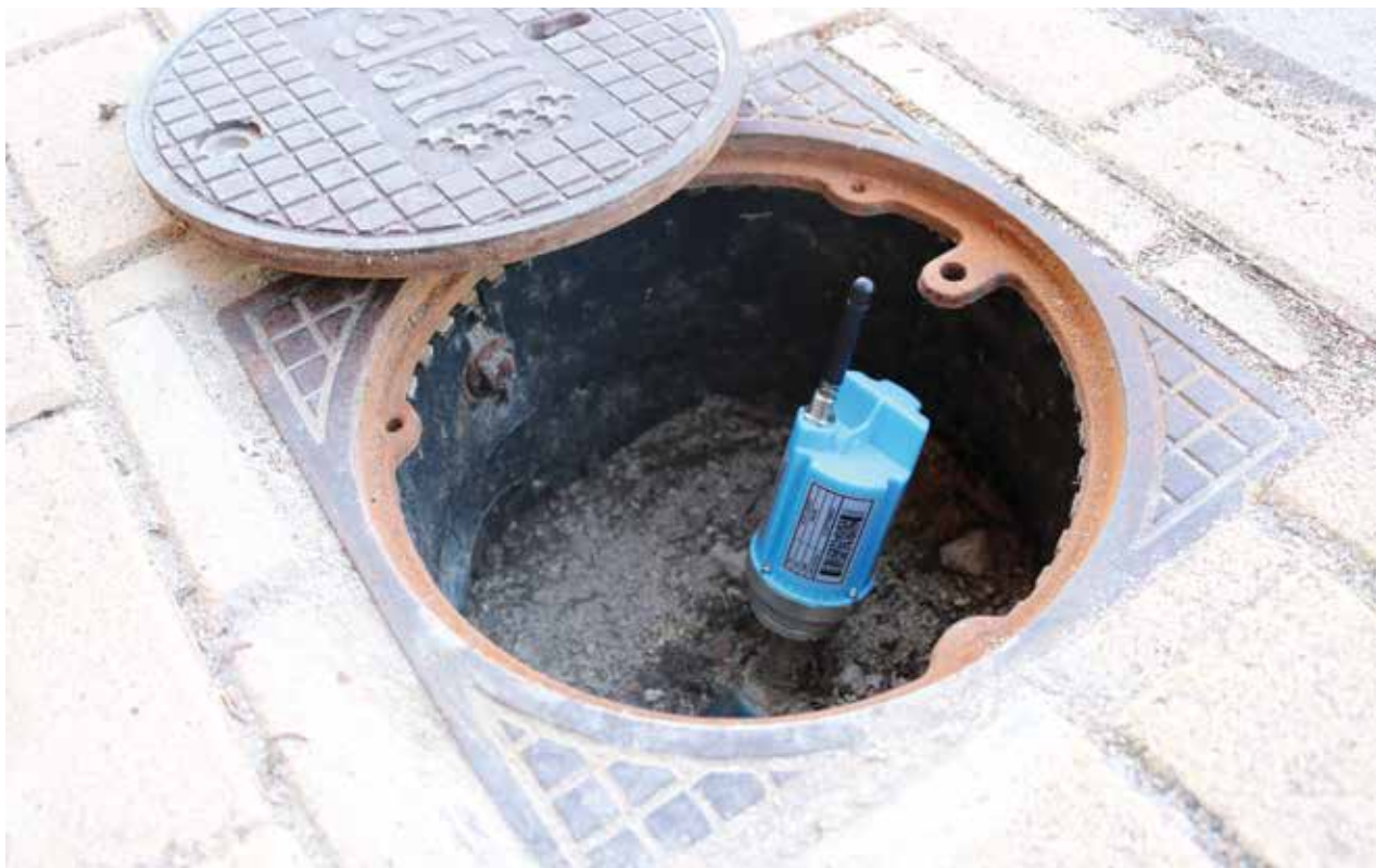
FIGURA 3. Permanet SU: Localizador remoto de fugas con integración directa en plataforma de gestión y correlación automática.
