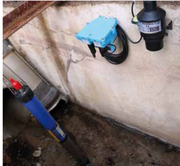
FIGURA 5. Solución integral para responder al RDPH: limnómetro Sonicsens 3 y sonda Aquatroll para la monitorización de alivios.
