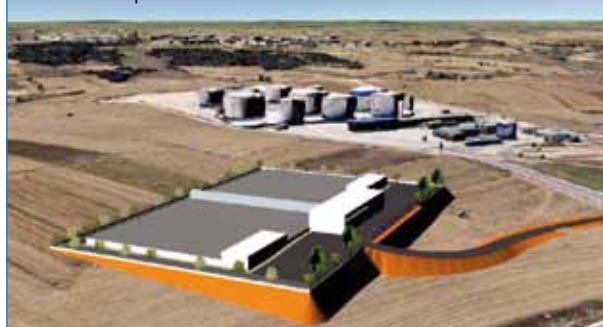
Futuros depósitos de Cortes.
