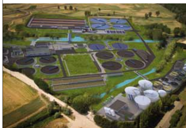
Ampliación de la EDAR de Burgos.
