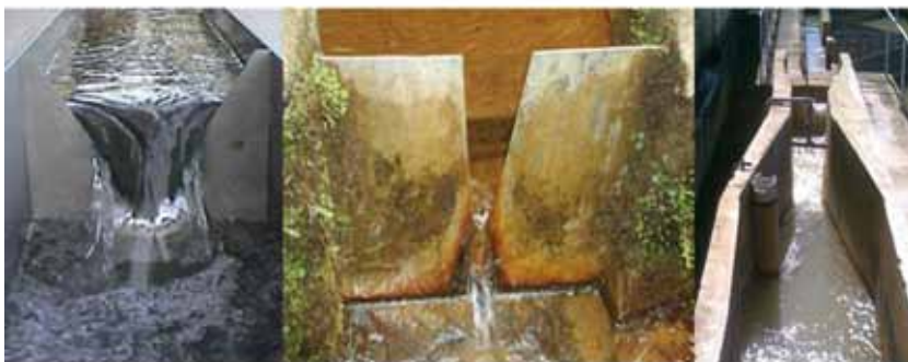
Diferentes vertederos y canales Parshall
