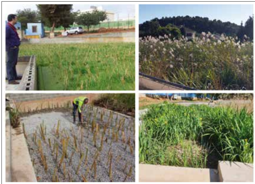
FIGURA 3. Imágenes del tratamiento terciario en la puesta en marcha (izquierda) y años después (derecha).
