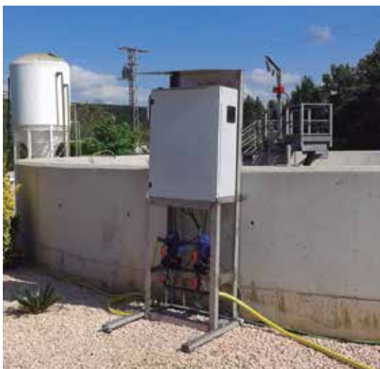
FIGURA 1. Sistema de dosificación instalado en la EDAR de Lloc nou d'en Fenollet.
