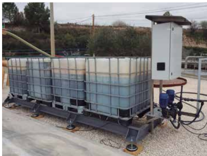
FIGURA 2. Sistema de dosificación instalado en la EDAR de Ontinyent-Agullent.
