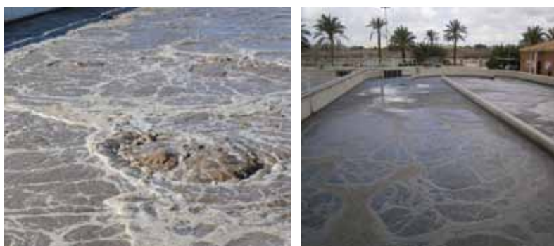
Figura 8. EDAR 4, antes y después de la sustitución de los difusores.
