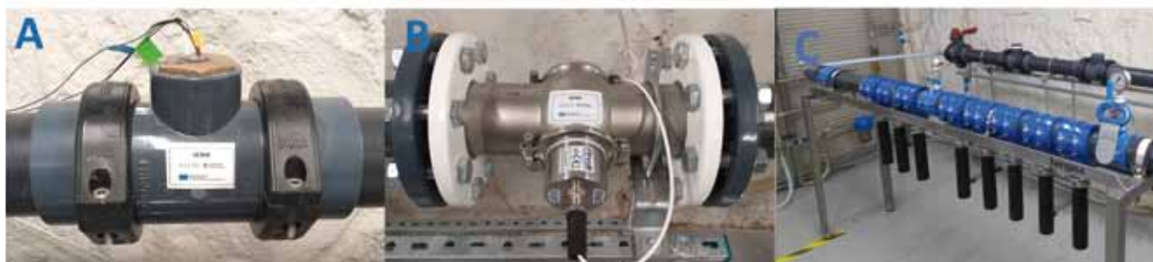
FIGURA 2. Sensor óptico (A) y sensor bioelectroquímico (B) instalados en el módulo, y sistema de testigos (C).
