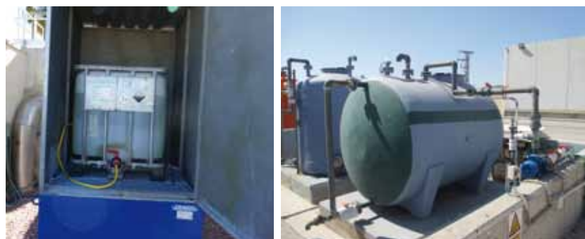
FIGURA 1. Depósitos de hipoclorito instalados en las EDAR.
