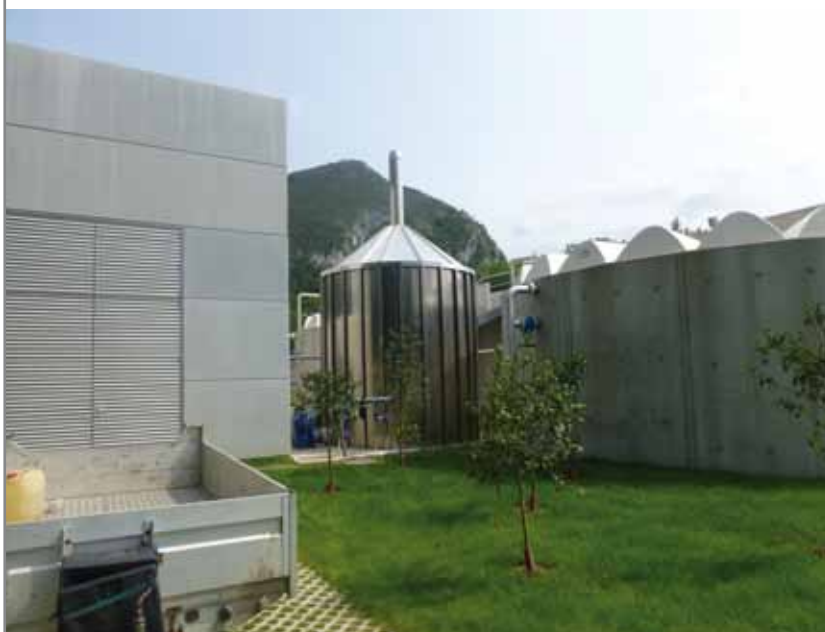
Figura 4. Biofiltro percolador para eliminación de olores del edificio de deshidratación de fangos.
