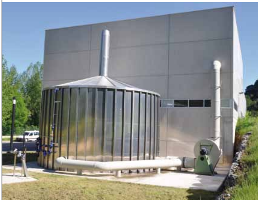
Figura 3. Biofiltro percolador para eliminación de olores del edificio de pretratamiento.
