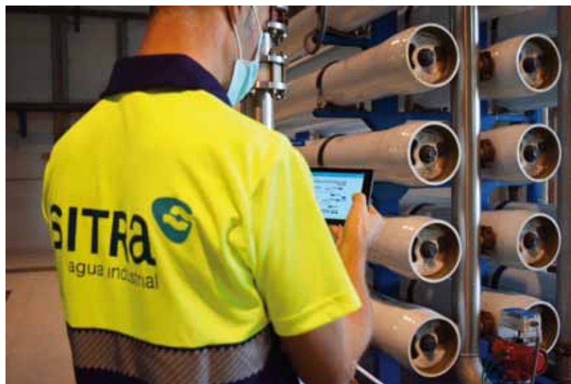
FIGURA 1. Módulos de ósmosis inversa.
