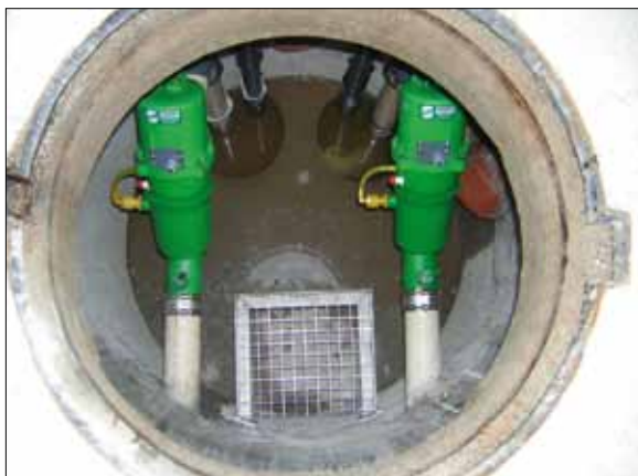
Figura 2. Válvula de vacío situada en el interior del pozo que recibe las aguas residuales por gravedad (izquierda de la imagen) y válvula situada en una arqueta separada, en seco (derecha).
