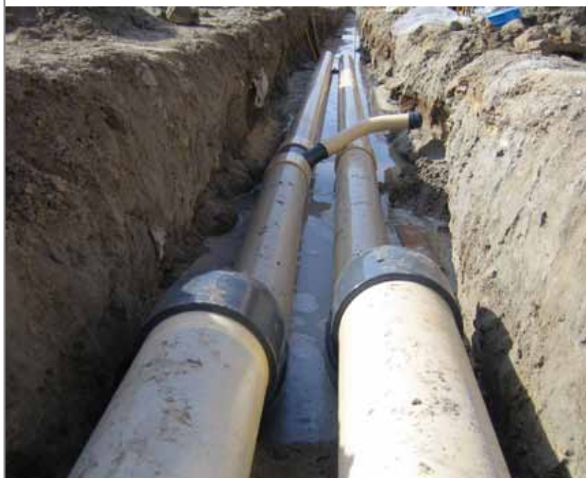
Figura 3. Tuberías montadas por encima del nivel freático.
