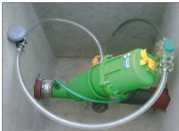
Figura 2. Válvula de vacío situada en el interior del pozo que recibe las aguas residuales por gravedad (izquierda de la imagen) y válvula situada en una arqueta separada, en seco (derecha).
