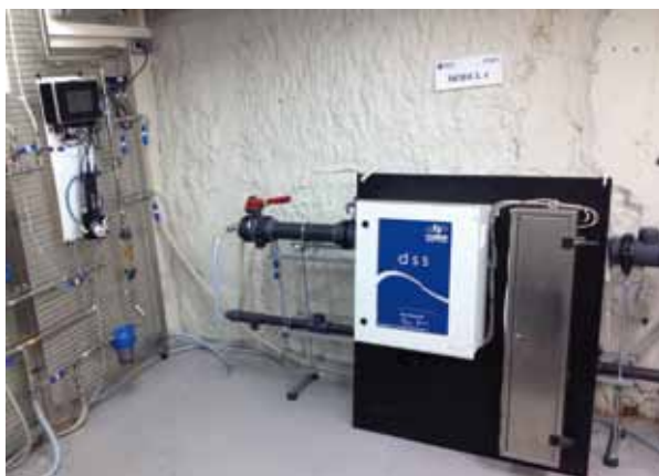
FIGURA 1. Equipo DSS de Enkrott en la Plataforma de Sensores de Aigües de Barcelona.
