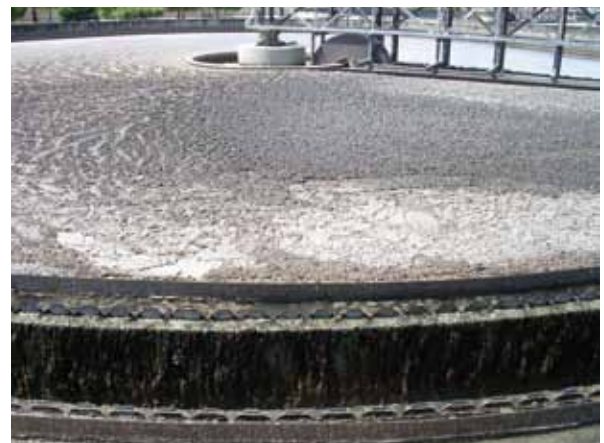
FIGURA 1. Problemas de separación del fango activo: episodio de bulking (izquierda) y episodio de foaming (derecha).
