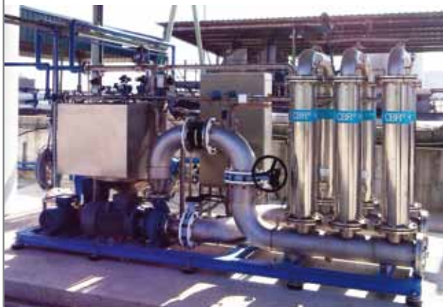
Figura 1. Skid de filtración cerámica en proceso MBR para tratamiento de agua residual de la producción de aceite de oliva (120 m 3 /día).
