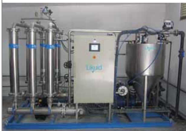
Figura 2. Skid de filtración cerámica para ultrafiltración de agua residual aceitosa proveniente de lavado de motores (50 m 3 /día).
