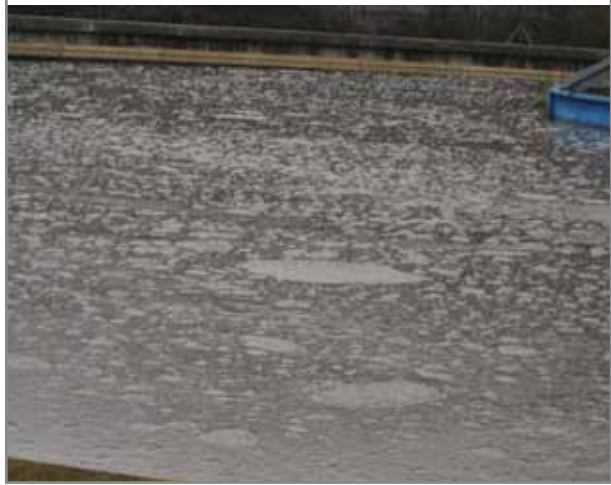
Figura 3. Flotación de los fangos en el clarificador.
