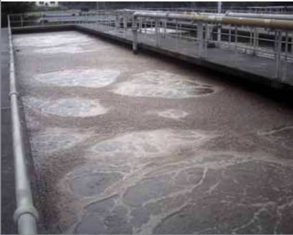
Figura 2. Espumas en el reactor.
