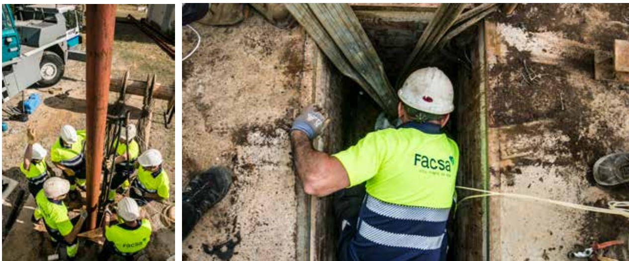
FIGURA 4. Montajes de un pozo de agua potable.
