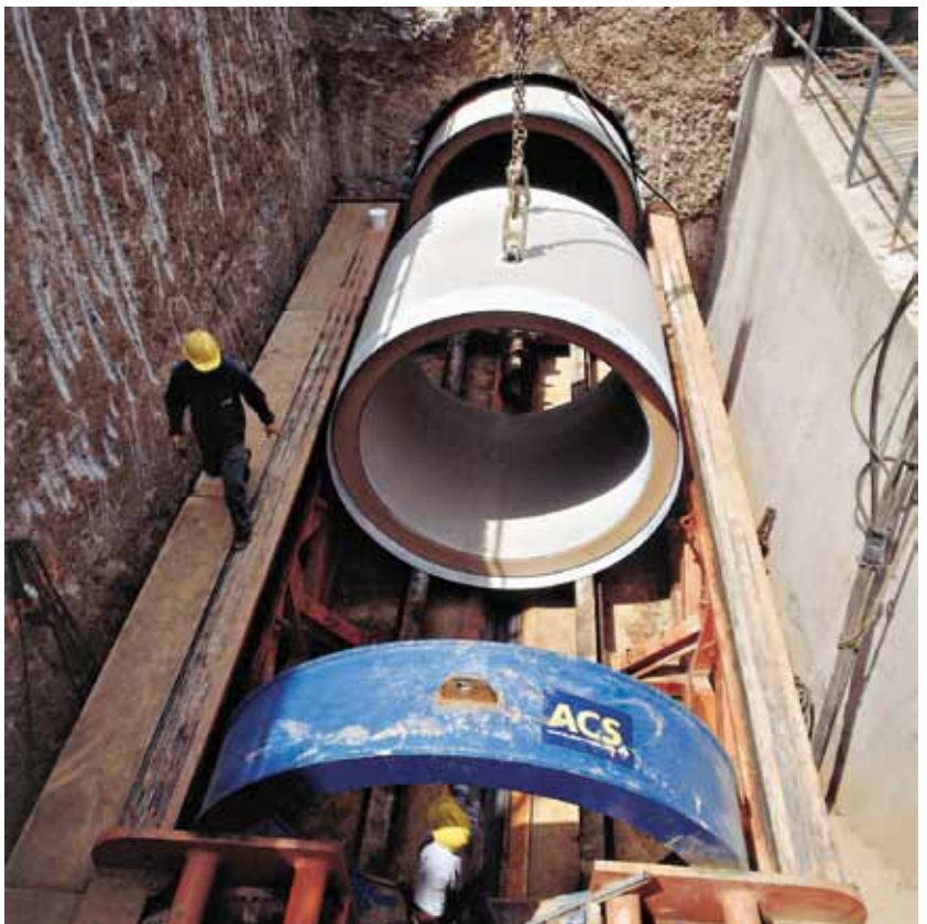
FIGURA 7. Obra de tubo colocado en hincas.
