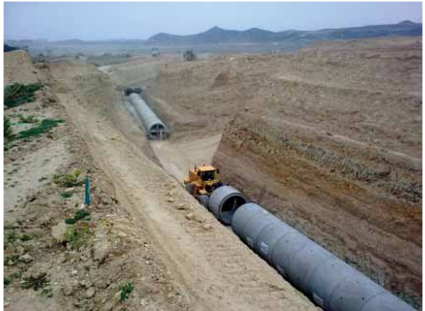
FIGURA 6. Ejecución de obra.
