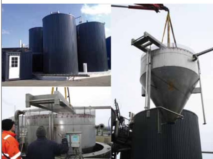
Figura 4. Reforma del reactor MBBR Anita Mox existente en el reactor IFAS Anita Mox.
